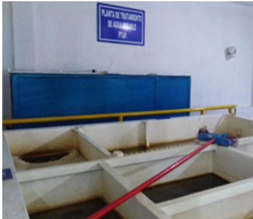
Fotografía 16. Disposición interna de la PTAP, en la que se realizan los procesos de coagulación, floculación y sedimentación. Tomada por Liza Gaitán (2019).
