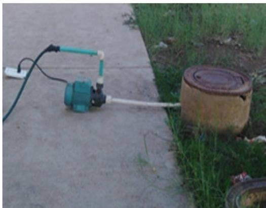
Fotografía 22. Turbina en una vivienda de Patilla. Se utilizan para incrementar la potencia del agua que llega por las tuberías. Tomada por Liza Gaitán (2019).
