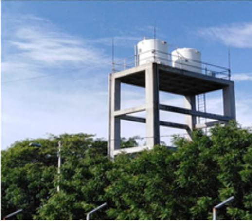
Fotografía 17. Tanques elevados de las comunidades de Roche y Chancleta. Cada uno tiene una capacidad de almacenamiento de 18 000 litros. Tomada por Liza Gaitán (2019).
